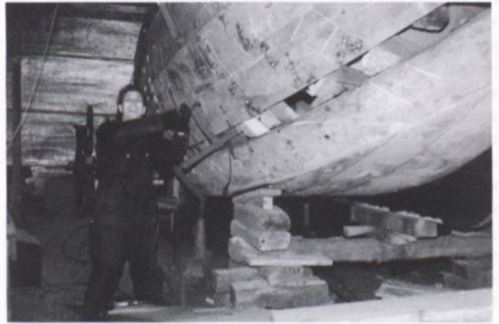
Het laatste stopgangetje, daar kun je nog mooi een lijmtangetje doorzetten.
